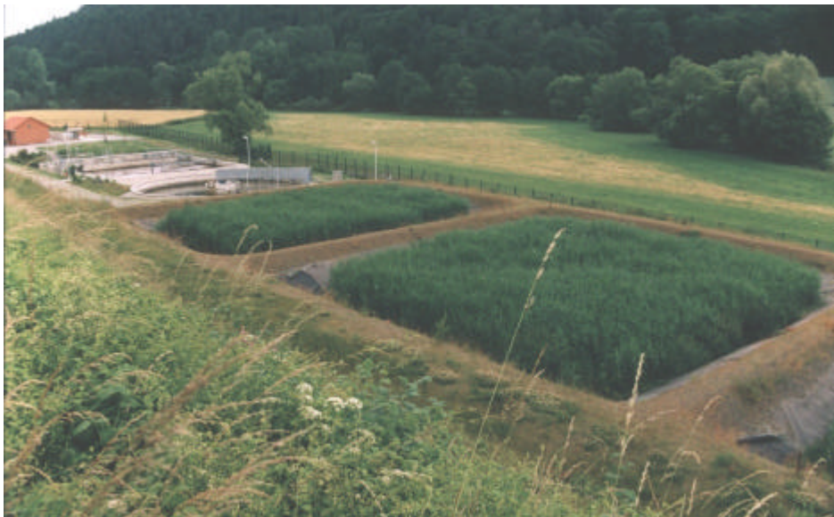
Klärschlammvererdung Naumburg, Teilbeete 1 und 2, Belebungsanlage im Hintergrund
