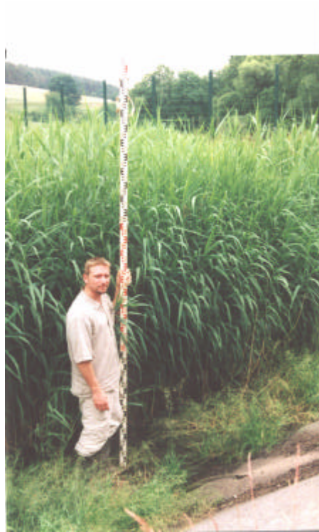
Klärschlammvererdungsanlage Naumburg (2.400 m 2 Bruttofläche) Wuchshöhe bis 4 m; Halmdichte bis 320 Stück/m 2
