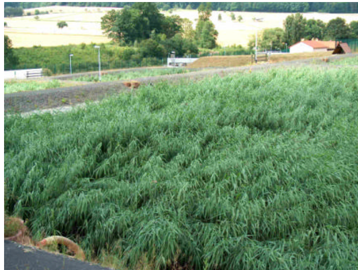
Klärschlammvererdungsanlage Bad Emstal (6000 m 2 Bruttofläche)
