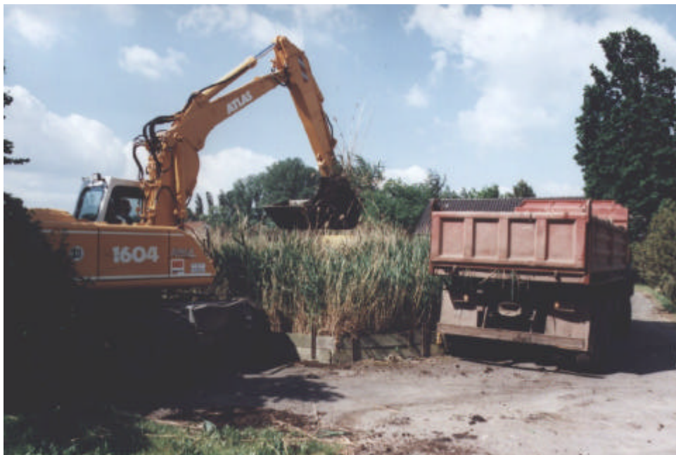
Räumung der Klärschlammbeete durch die Firma Köster im Jahr 2001
